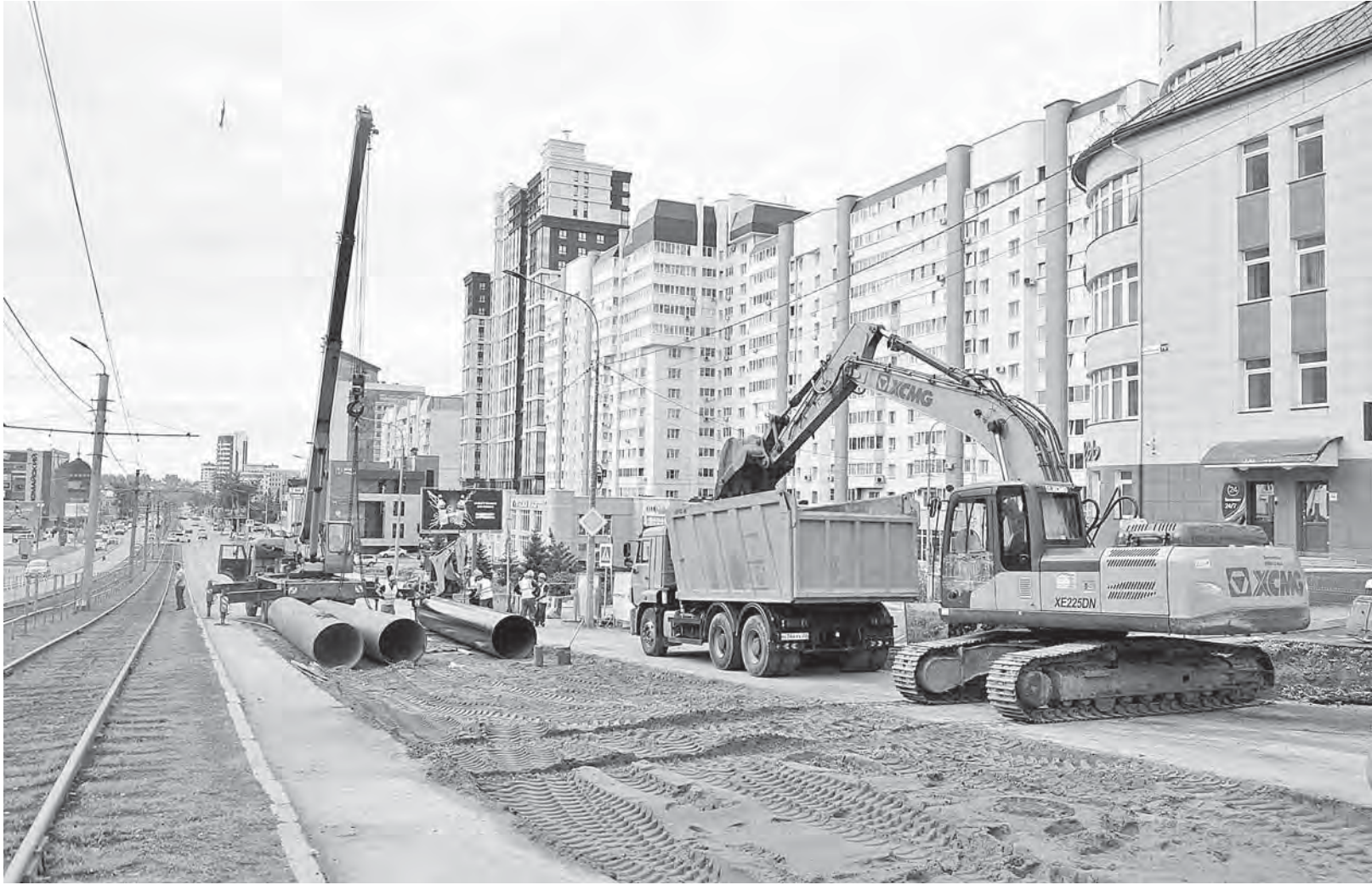
Ремонт инженерных сетей на пр. Красноармейском призван улучшить надежность коммуникаций на долгие годы.
