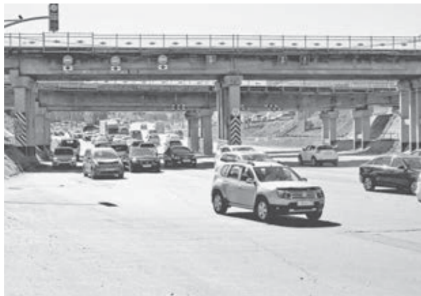
На пр. Строителей во время ремонта ведётся постоянный мониторинг дорожной обстановки.
