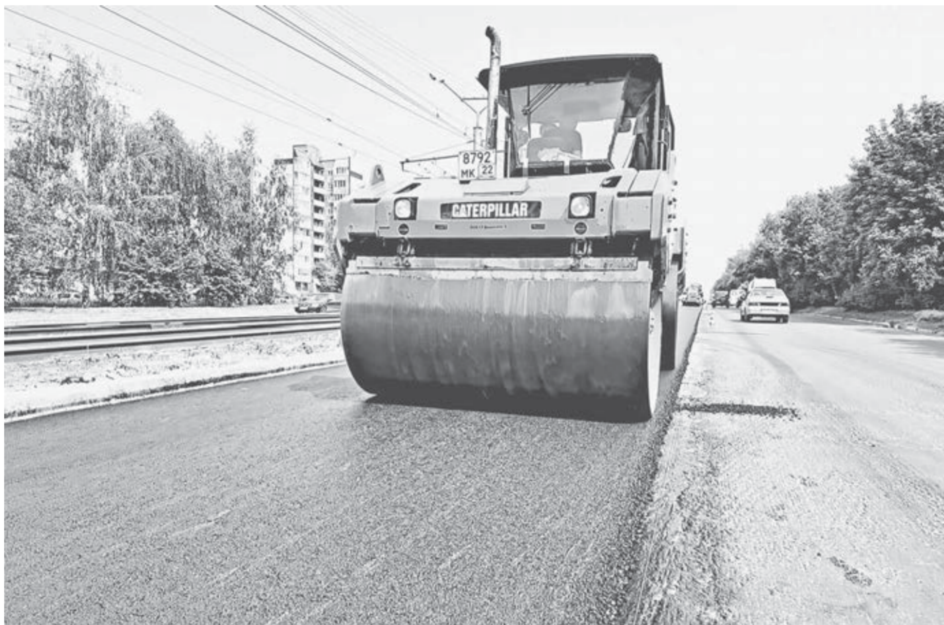
Протяжённость ремонтируемого участка ул. Попова от Павловского тракта до ул. Георгия Исакова составляет 4,83 км. Стоимость работ – 112,3 млн руб.
