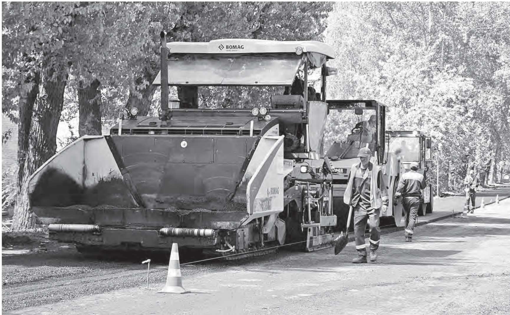
В 2024 году в рамках нацпроекта «Безопасные и качественные дороги» была капитально отремонтирована ул. Суворова.
