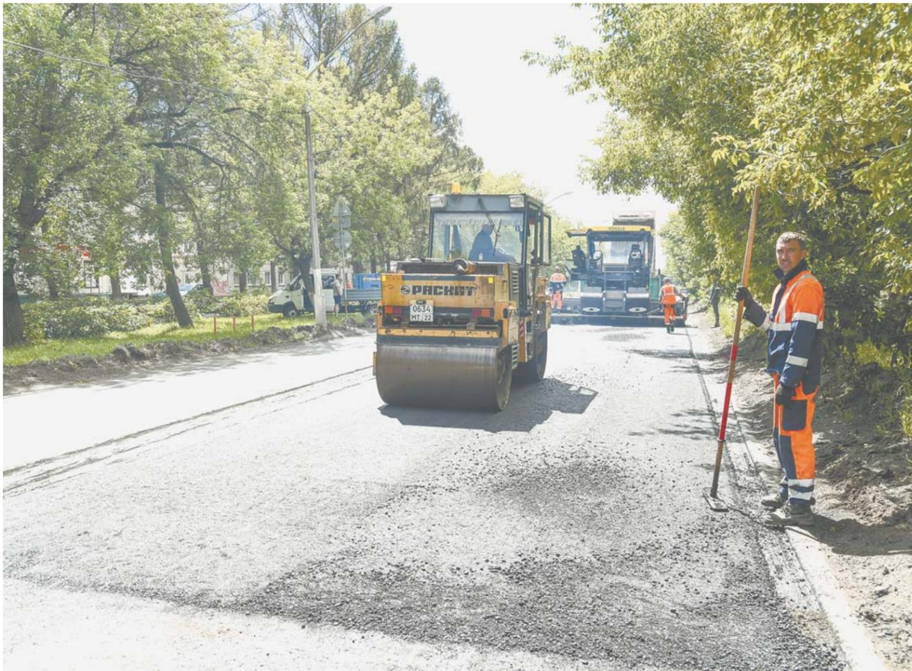
На пр. Дзержинского идет укладка выравнивающего слоя асфальтобетона.
