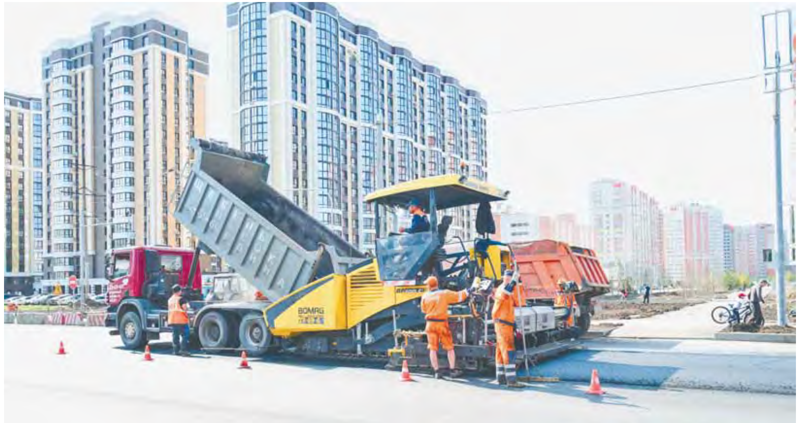
Активно продолжается ремонт и строительство автодорог в новых микрорайонах города.
