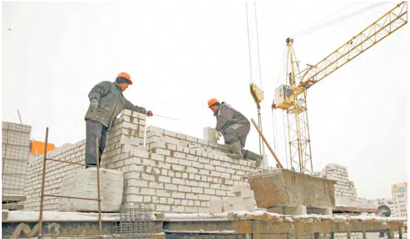
Строительные работы на объекте ведутся активными темпами.
