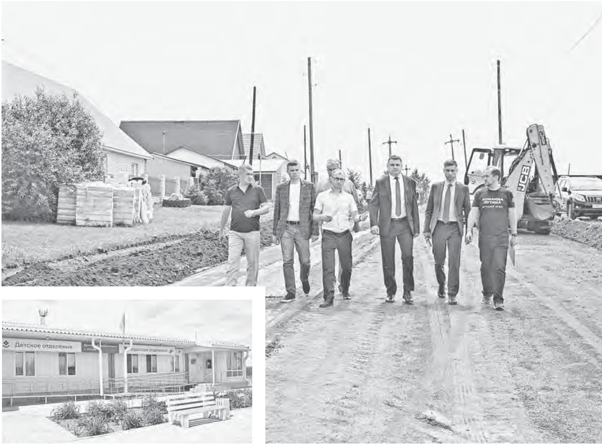
Ремонт дороги позволит жителям комфортно добираться к амбулатории.
