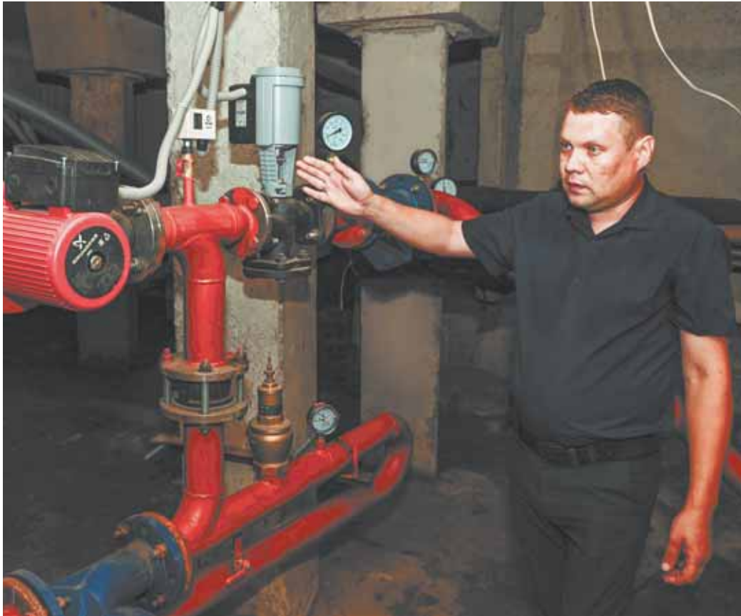
Погодозависимое оборудование регулирует подачу теплоносителя.
