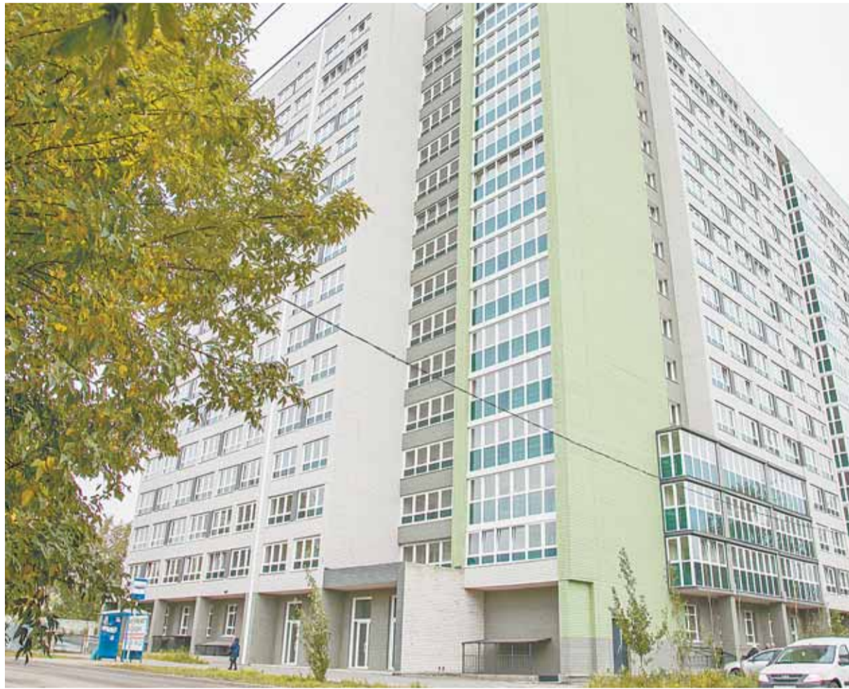
Завершения строительства дома ждут 300 семей будущих новоселов.
