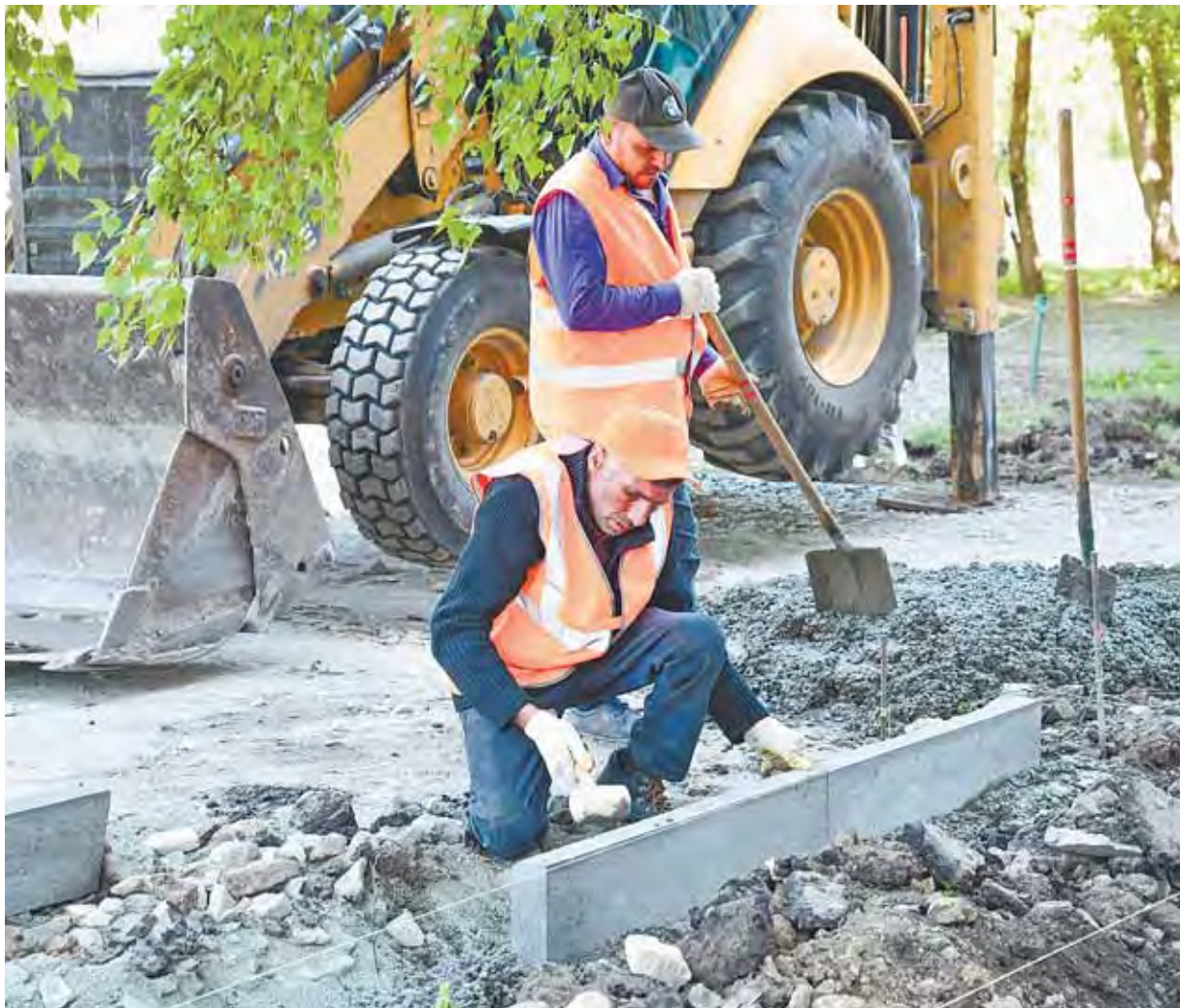
После ремонта двор на ул. Сиреневой, 1, станет комфортным для жителей.
