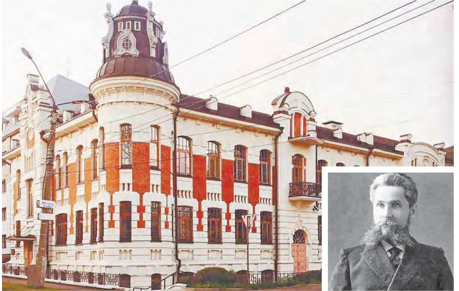
В начале XX века это здание, созданное в стиле модерн, являлось архитектурной доминантой Мостового переулка (ул. М. Горького).
