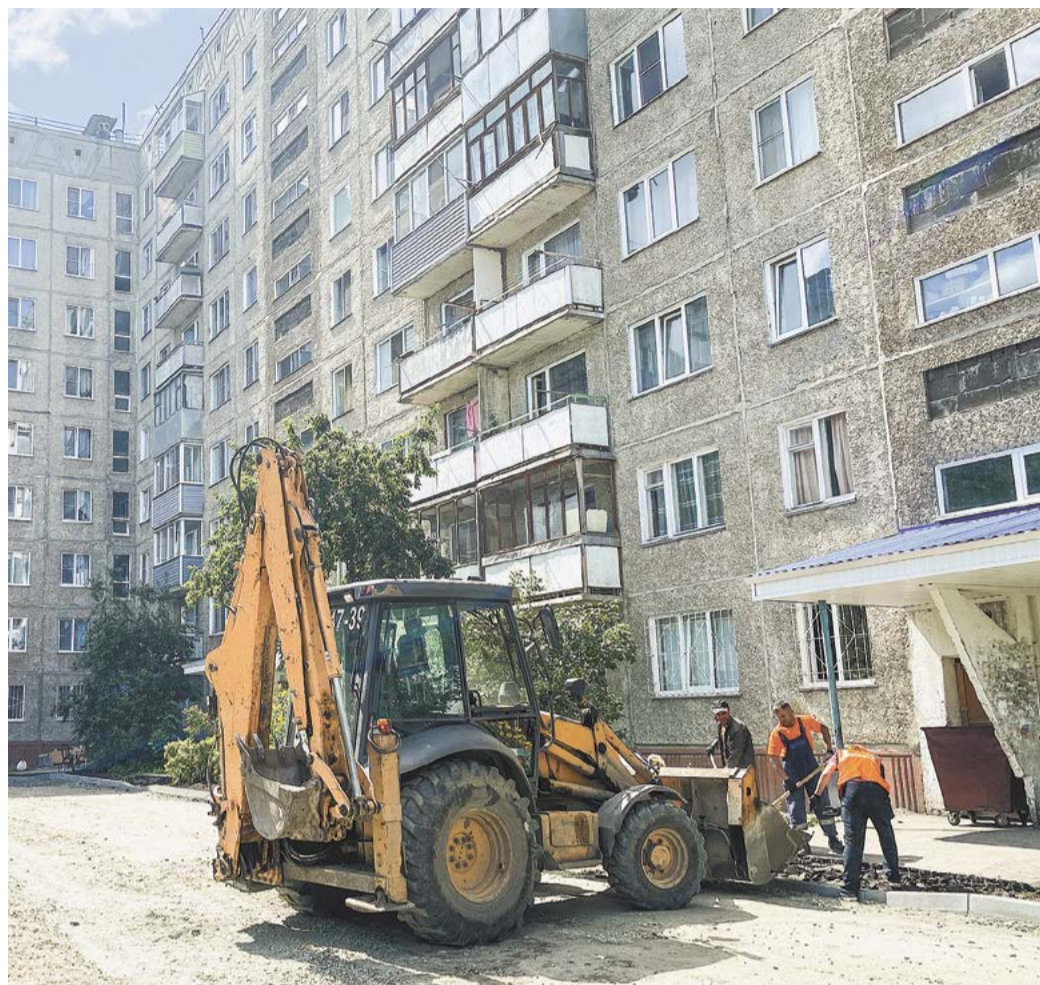
Идет ремонт двора на ул. Монтажников, 3.
