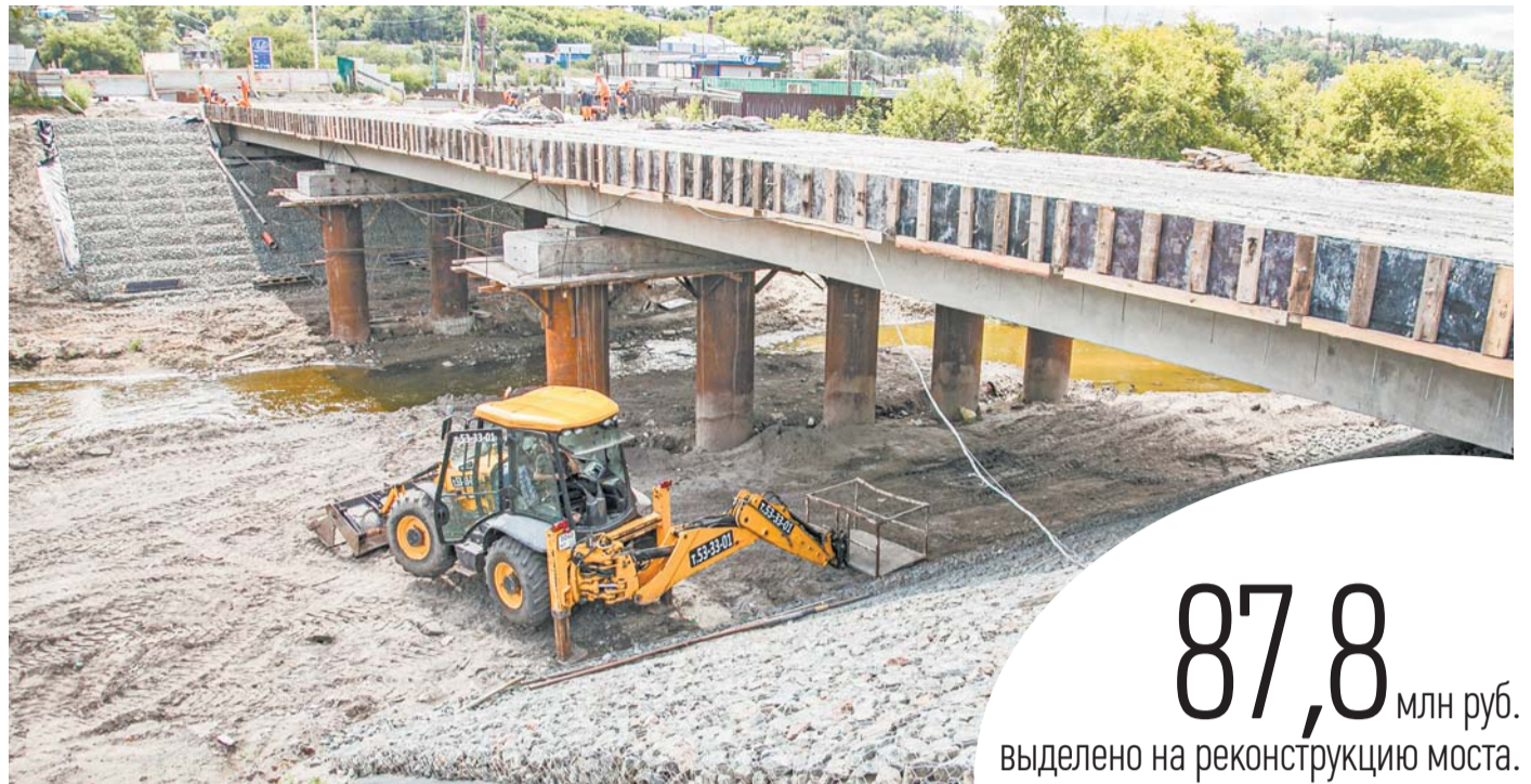
Работы на мосту на ул. Челюскинцев идут с опережением графика.
