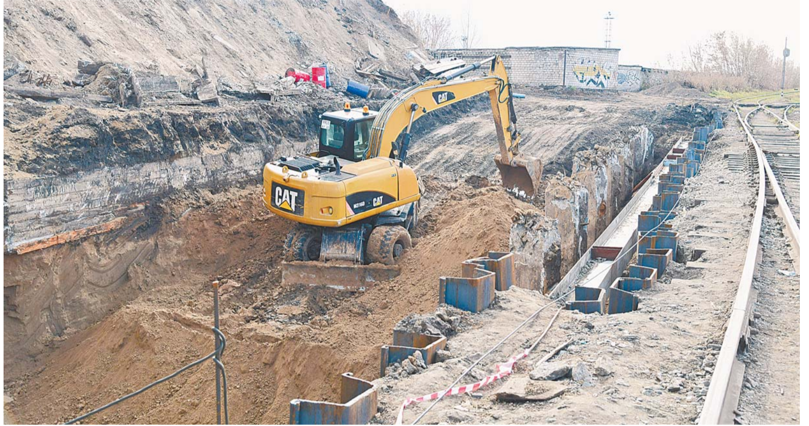
15 единиц техники работает на площадке по реконструкции моста.
