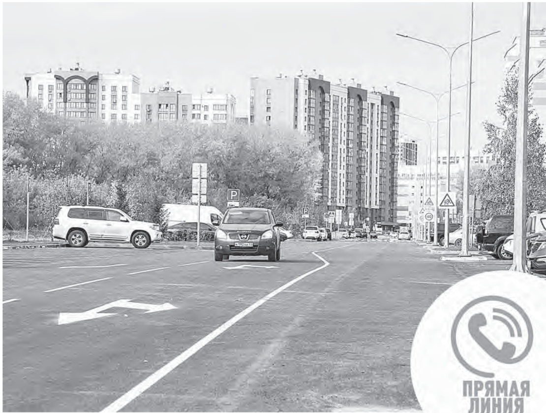
В сентябре завершено строительство важного участка улицы 280-летия Барнаула.
