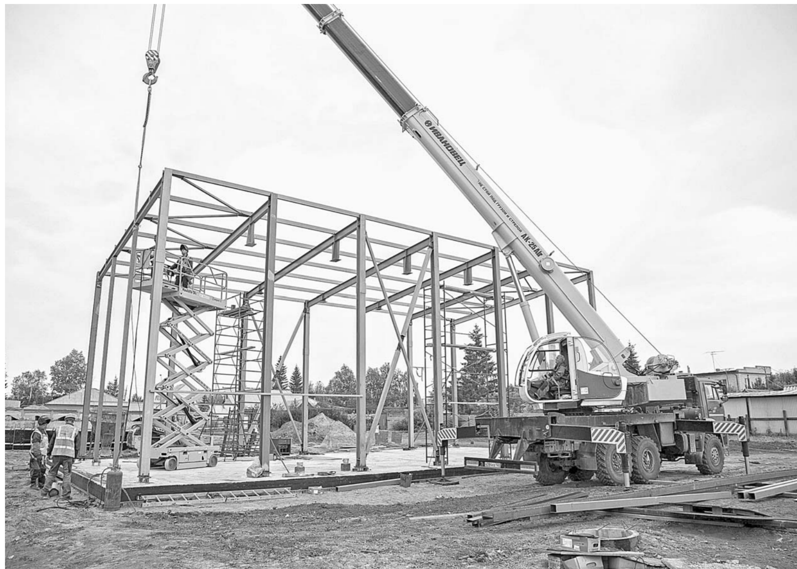
Ввод в эксплуатацию строящегося водозабора запланирован в конце 2022 года.
