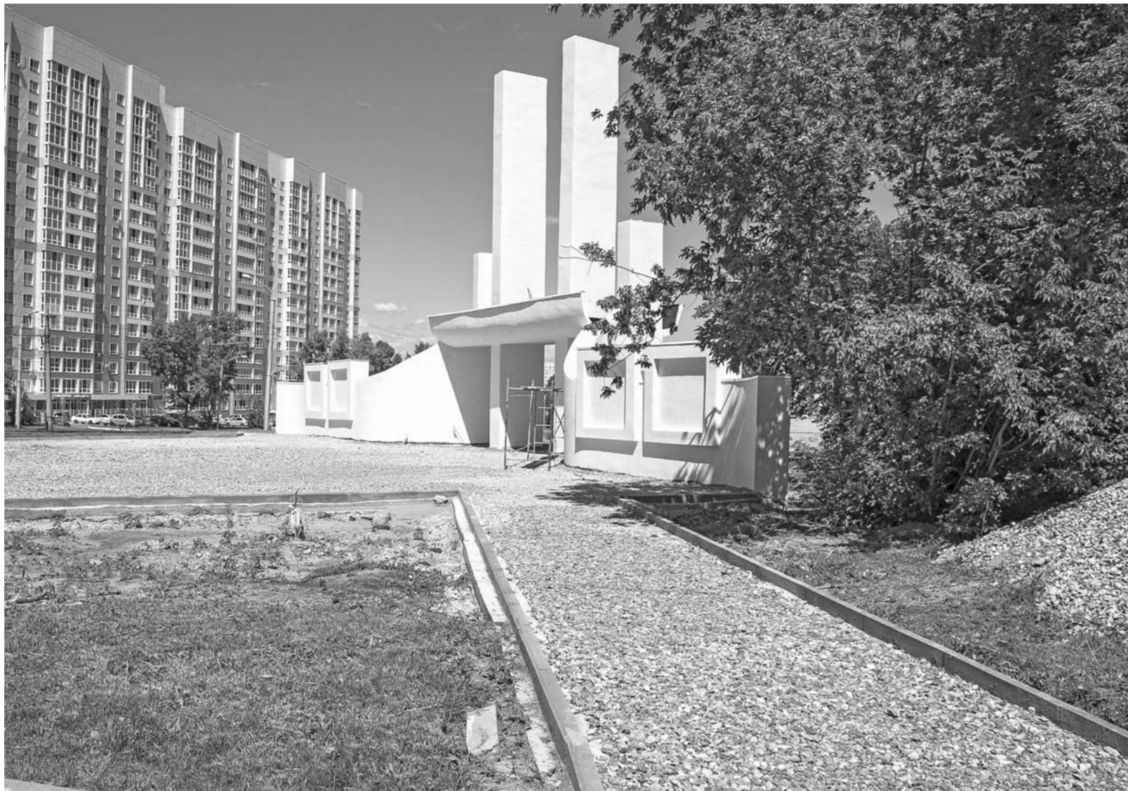
В ходе первого этапа благоустройства Юбилейного парка отремонтировали входную группу.
