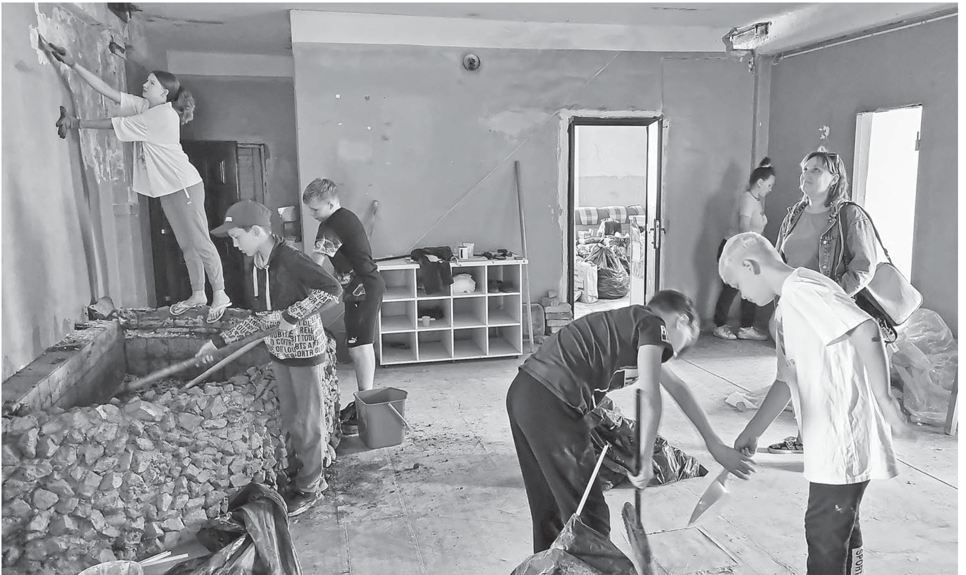
Принять участие в ремонте своего будущего дома хотят и взрослые, и подростки сообщества «Много деток — хорошо!».
