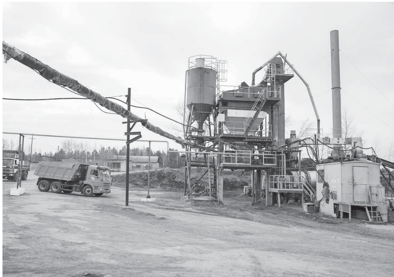
Запуск асфальтобетонного завода ускорит дорожный ремонт в Барнауле и повысит качество работ.
