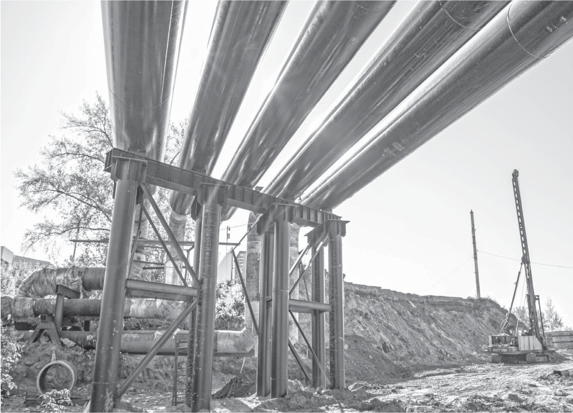
К началу отопительного сезона теплосеть в районе моста на Новом рынке будет готова.
