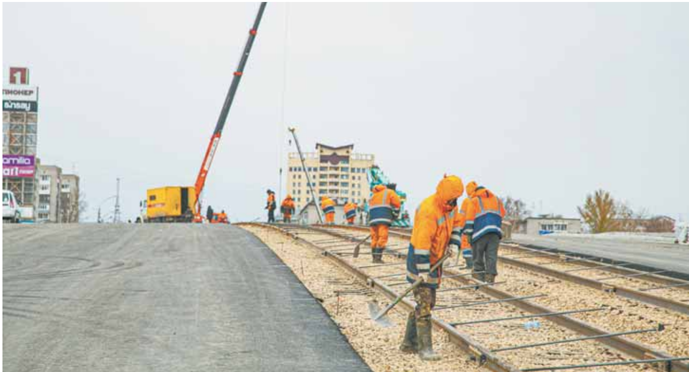
Сейчас на подъездах к мосту ведутся дорожные работы и укладка новых рельс.
