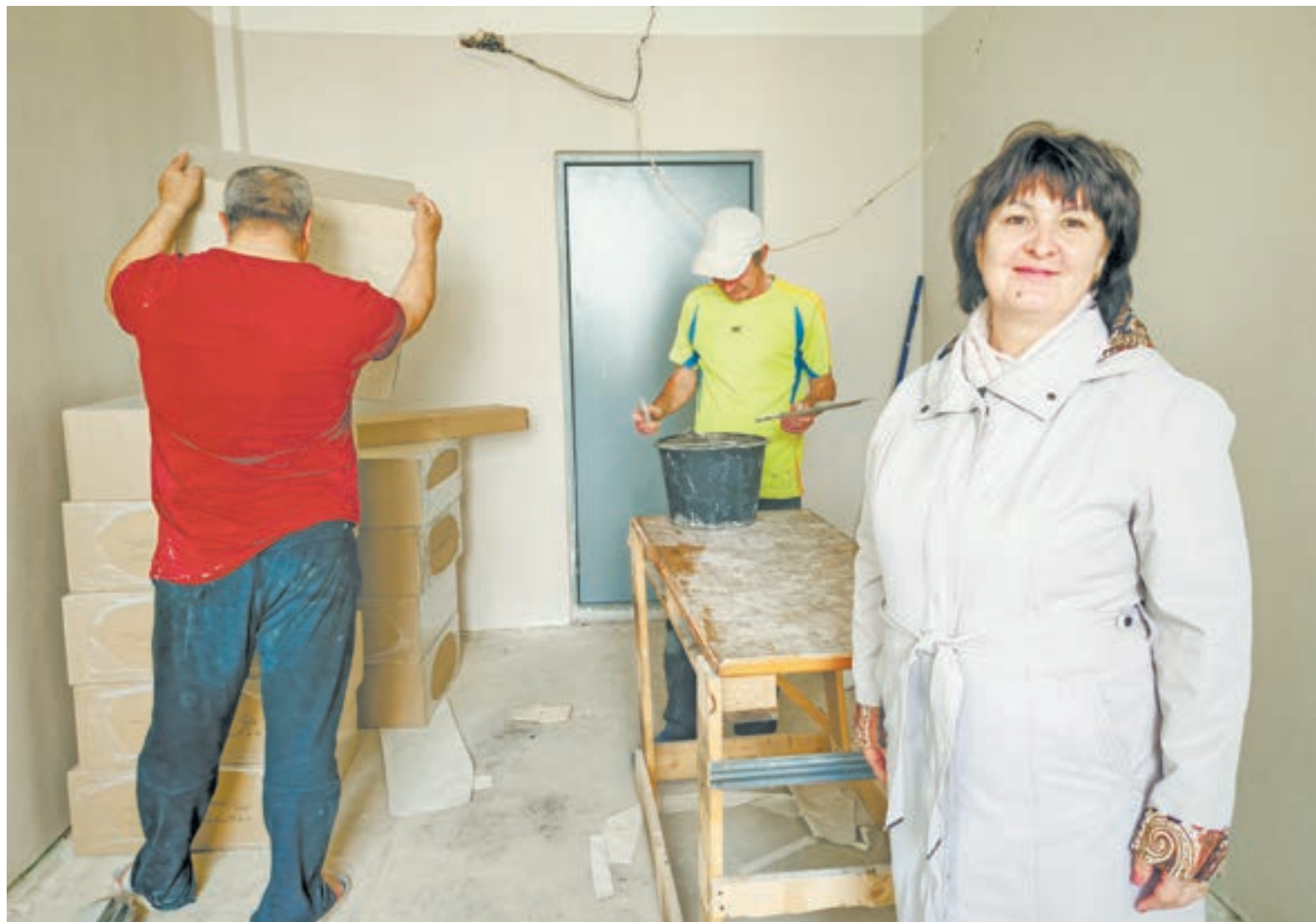
В новом помещении в разгаре ремонтные работы.
