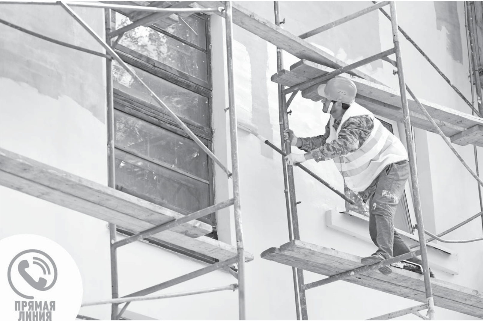
В Барнауле реализуются две программы капитального ремонта домов: региональная и муниципальная.
