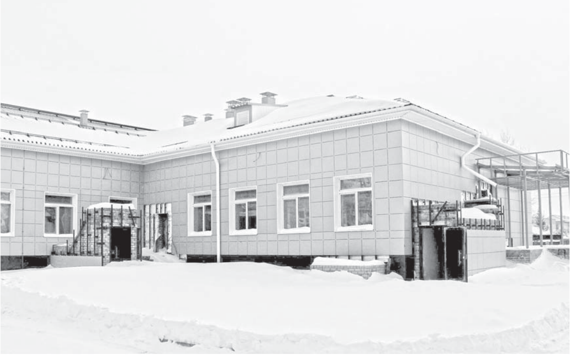
В одноэтажном пристрое строители начали внутреннюю отделку.
