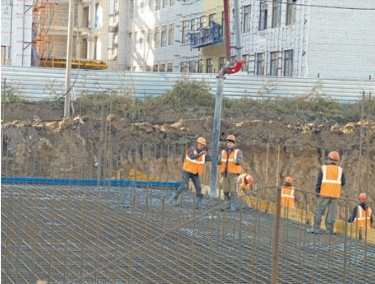
На площадке ведется устройство фундамента и начальной части нового корпуса поликлиники.
