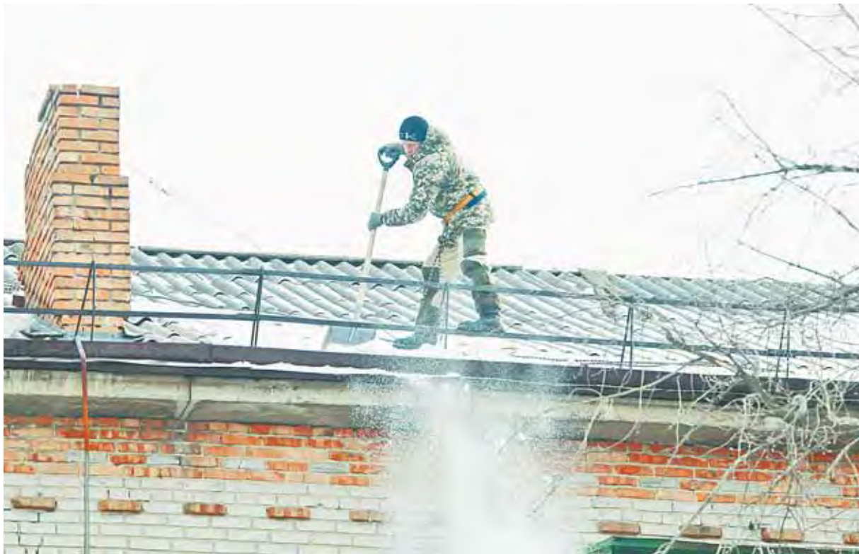
Северо-Западная, 222: работы по очистке кровель многоквартирных домов продолжаются.
