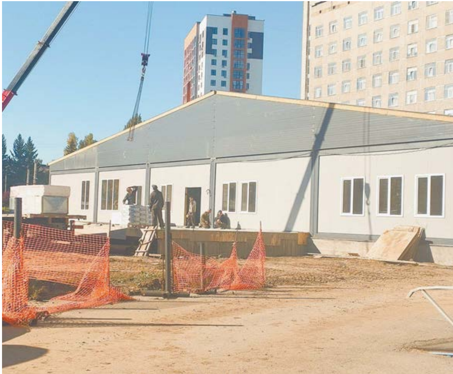
Основные строительно-монтажные работы планируют завершить в октябре.
