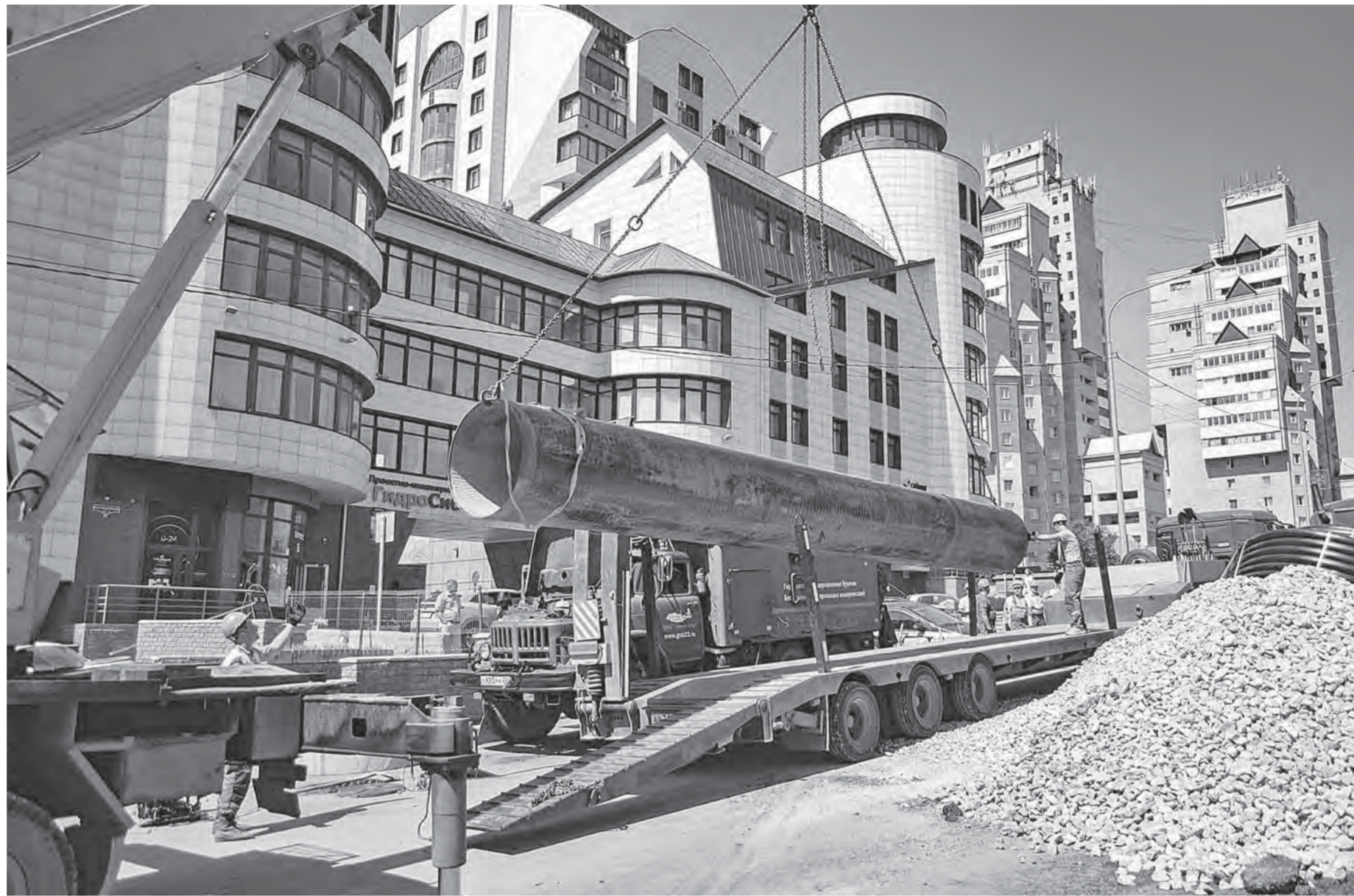
Участок инженерных коммуникаций на пр. Красноармейском – один из самых больших объектов ремонтной кампании.
