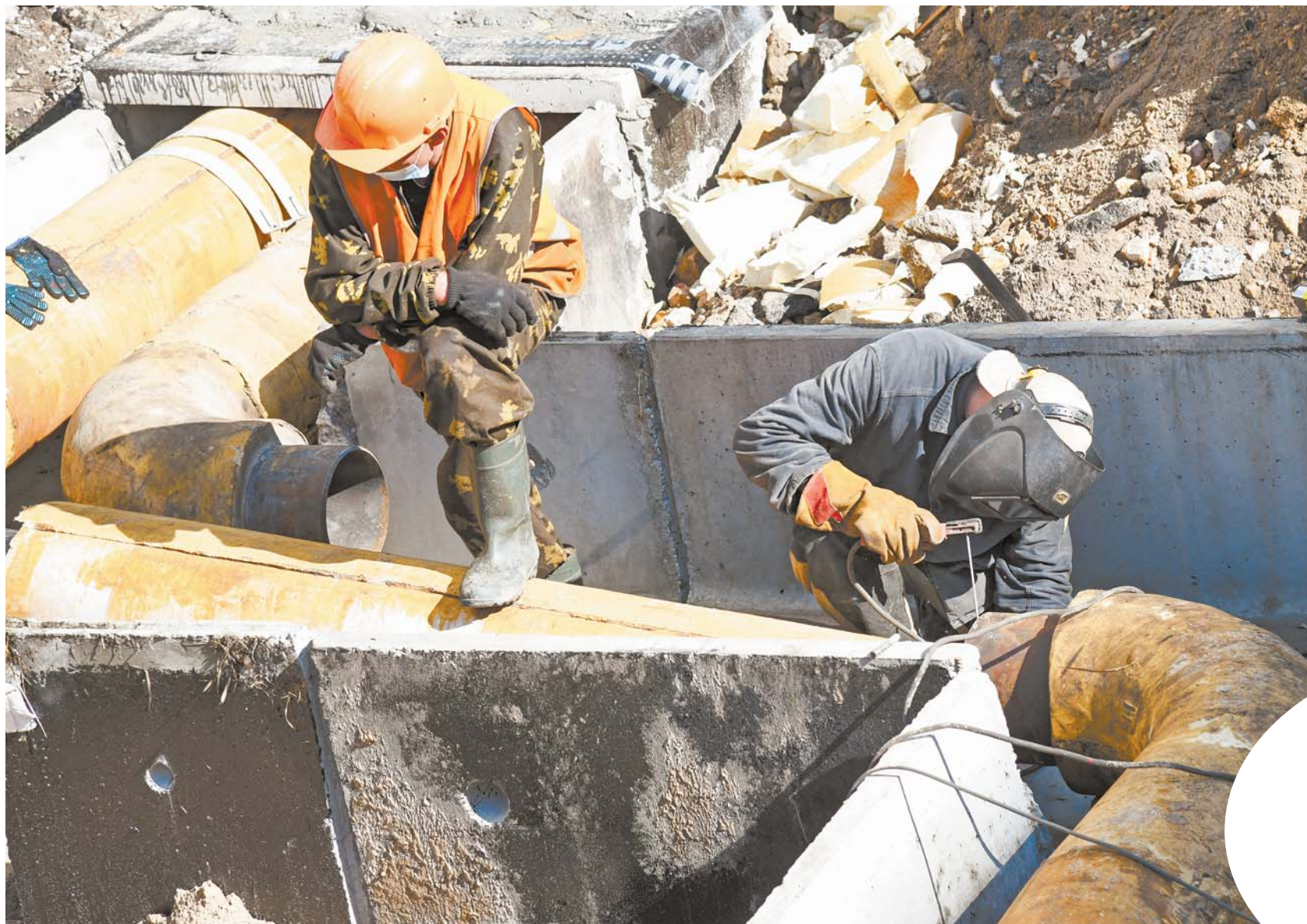
Барнаульским энергетикам удалось приблизиться к нормативным объемам переделки сетей – около 35 км. Это позволяет значительно повысить надежность теплоснабжения.
