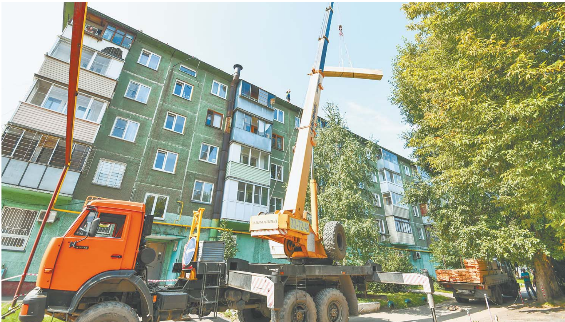
Капитальный ремонт крыши этого дома строители планируют завершить в сентябре.
