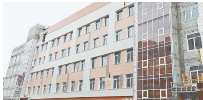
Строительство нового корпуса городской поликлиники № 14.
