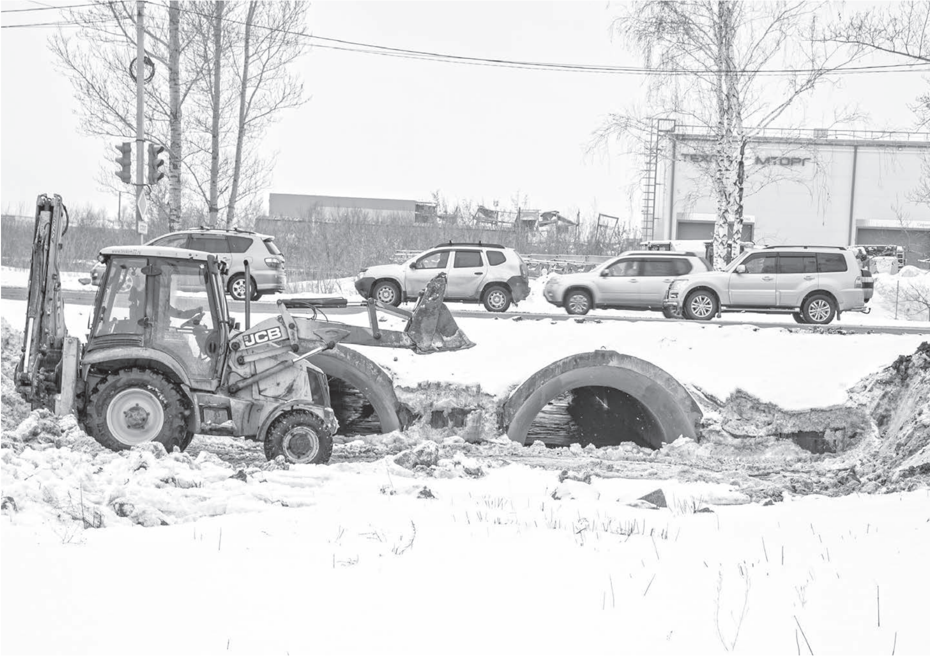
В районе пересечения Павловского тракта и улицы Просторной очищают водопропускные сооружения.
