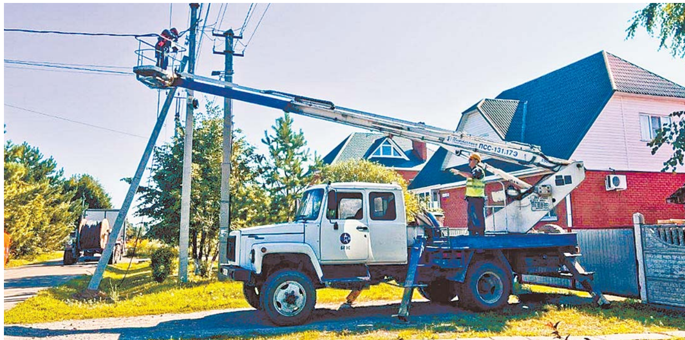
После реконструкции сетей у жителей нет проблем с электроэнергией.
