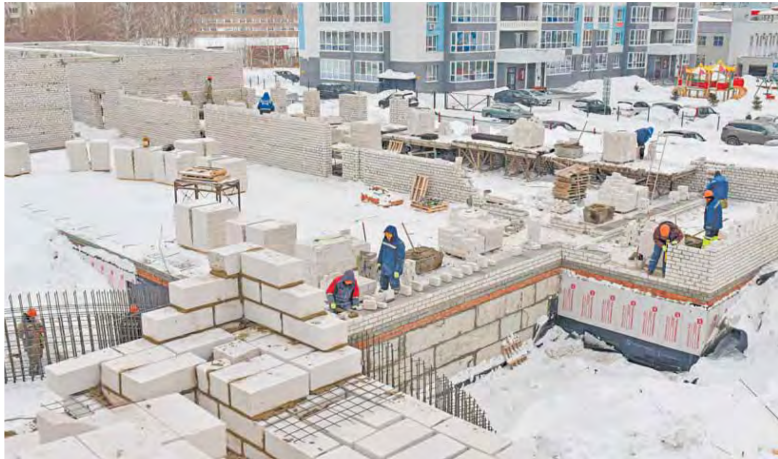
Работы на объекте ведутся в соответствии с графиком.
