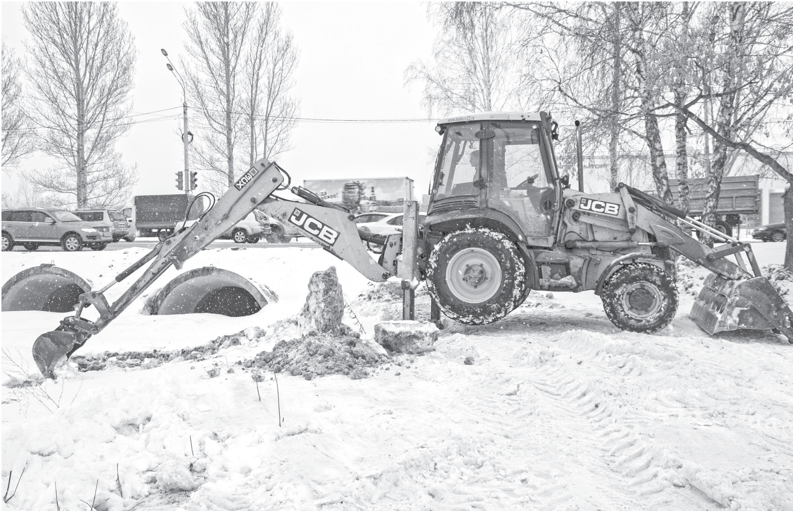
В начале весны службы занимаются очисткой водопропускных сооружений и ворошением снега.
