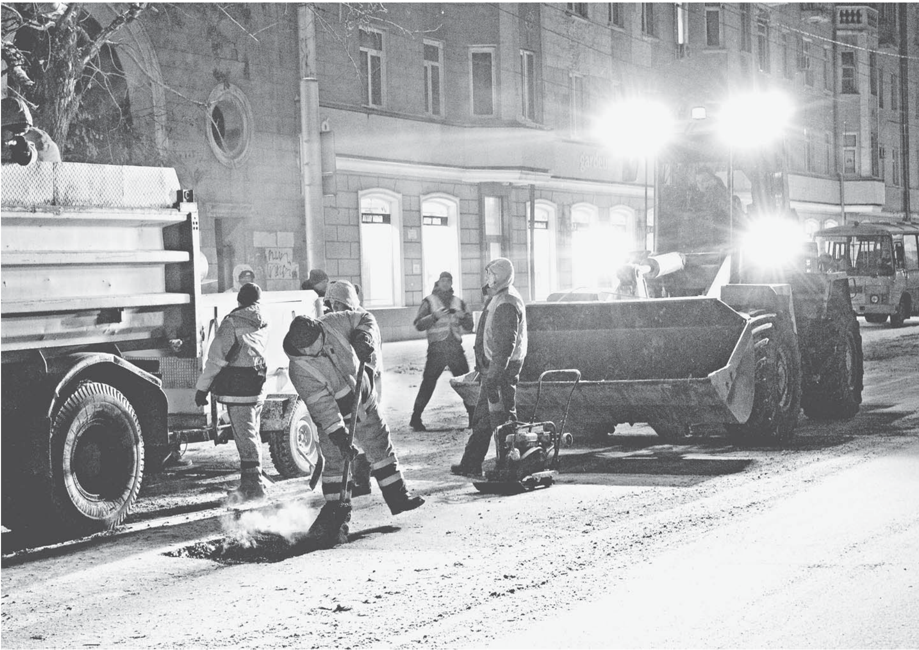
Чтобы не создавать дополнительной нагрузки на движение транспорта днем, укладку холодного асфальта бригады ведут в ночное время.
