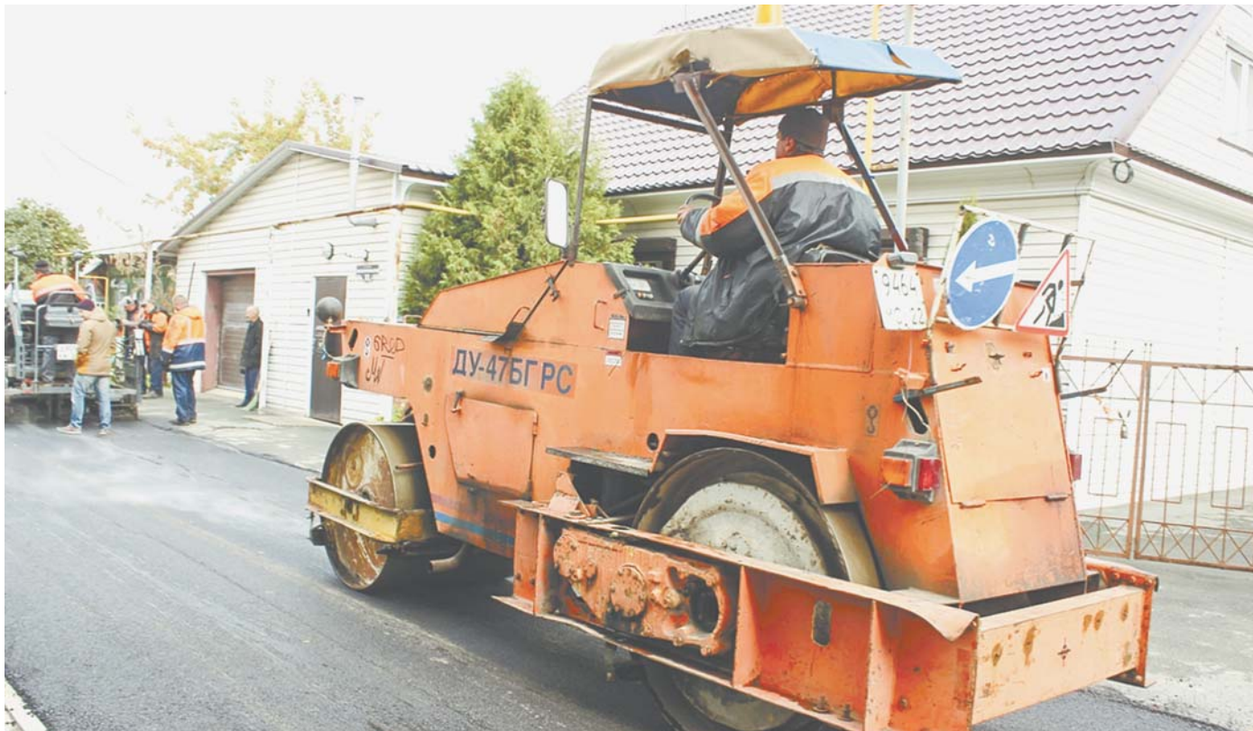
Ремонт дорог частного сектора идет во всех районах Барнаула.
