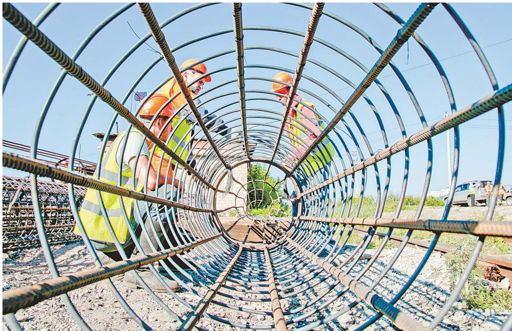
Мостостроители монтируют металлический каркас буронабивной сваи.
