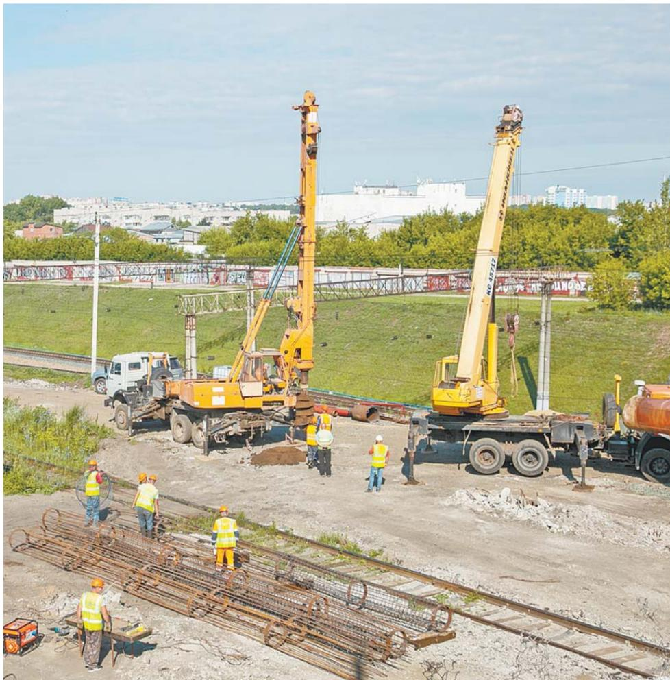
Армированные металлом буронабивные сваи станут прочной опорой для теплосети.
