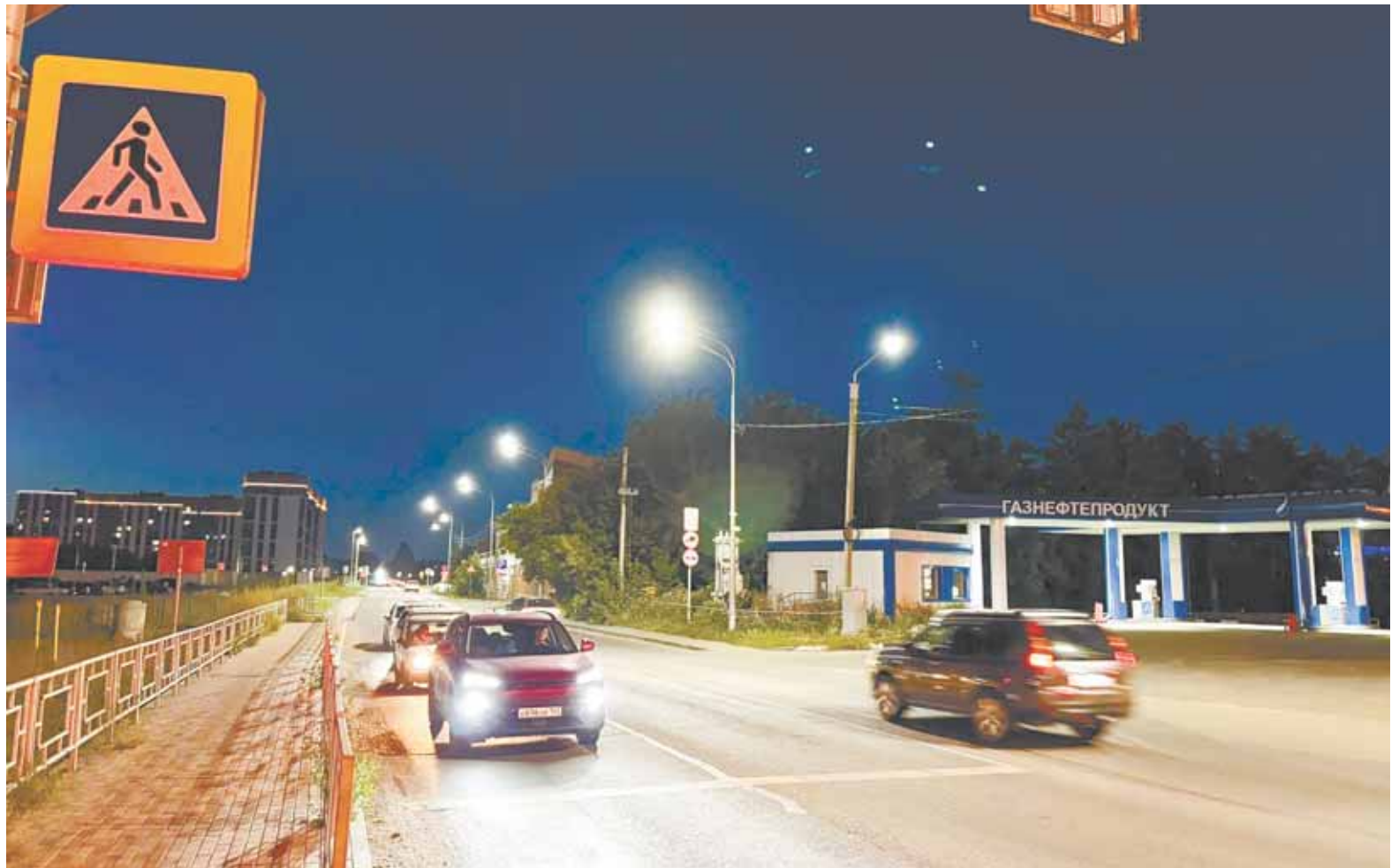
На ул. Просторной обустроили линию освещения протяженностью 767 метров.
