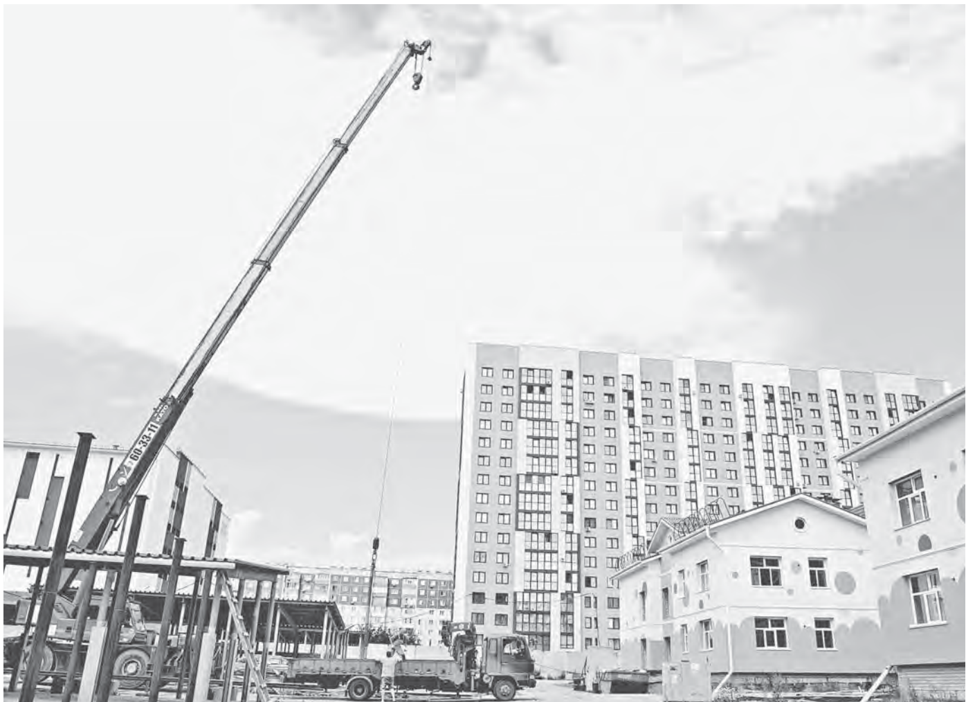
На строящемся объекте работы ведутся как внутри здания, так и на прилегающей территории.
