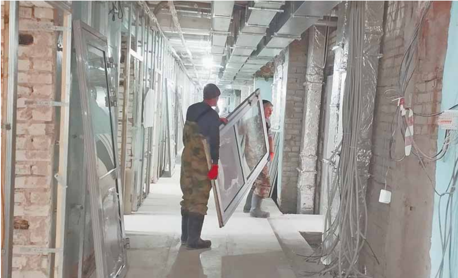
Строители завершают монтаж внутренних перегородок и готовят помещения к внутренней отделке.
