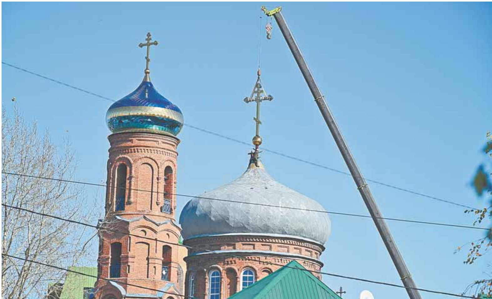
Помимо замены креста, на центральном куполе проводятся работы по его очистке и покраске.
