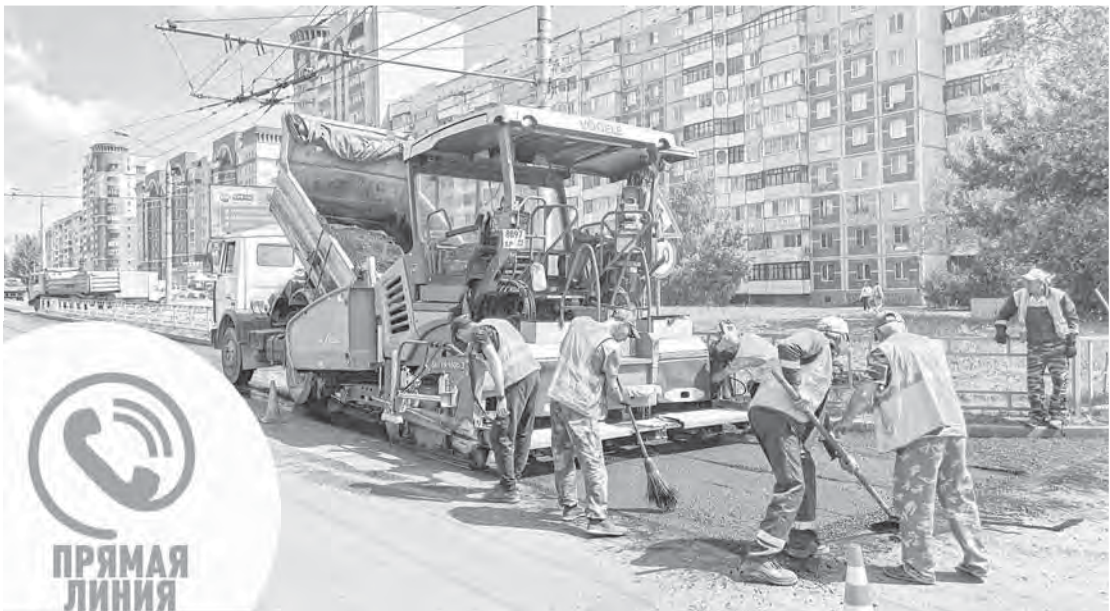
В рамках нацпроекта идет ремонт дорожного полотна на ул. Малахова.
