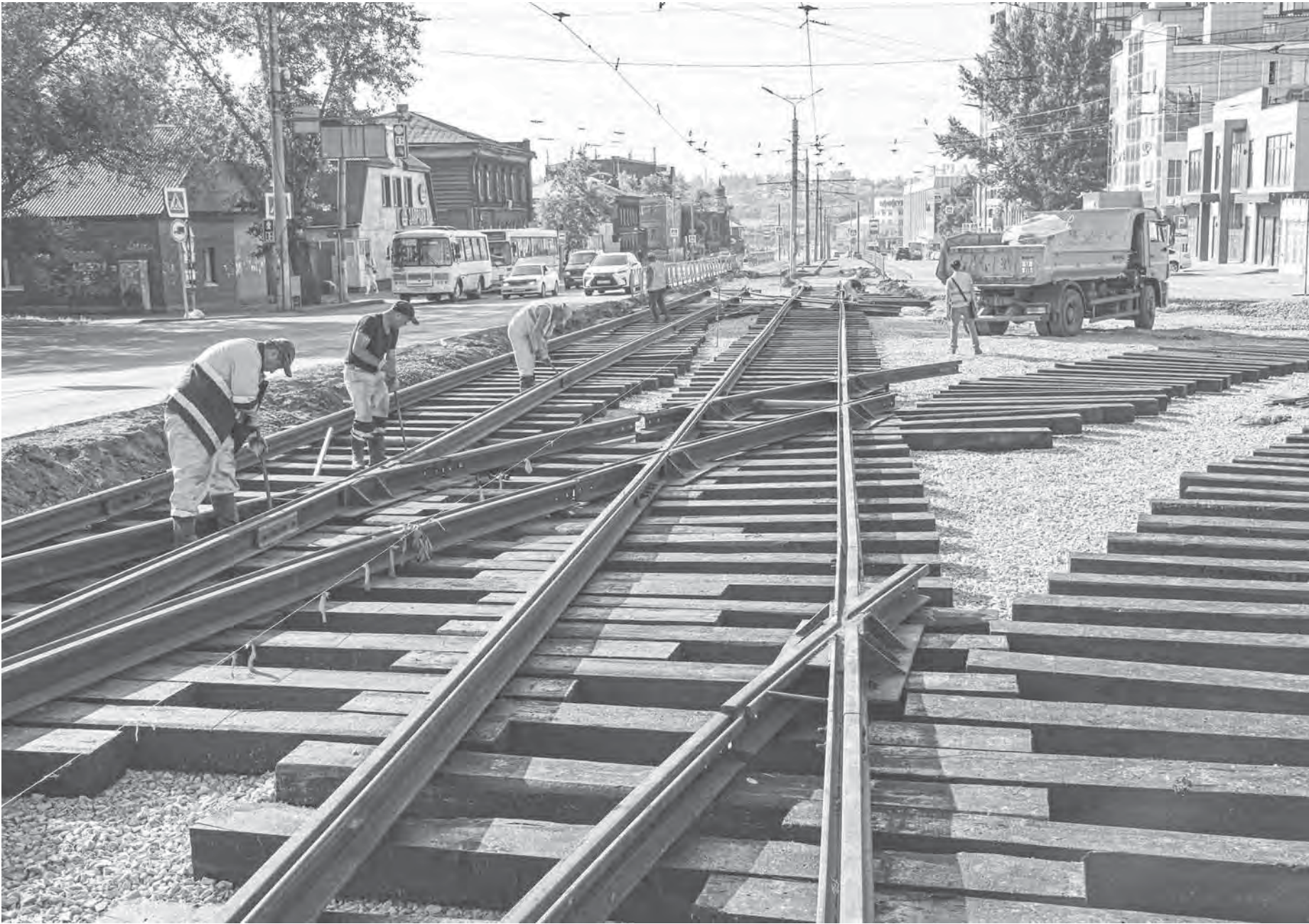
Общий объем выполненных работ по ремонту трамвайных путей на пересечении пр. Красноармейского и ул. Анатолия составляет 40%.
