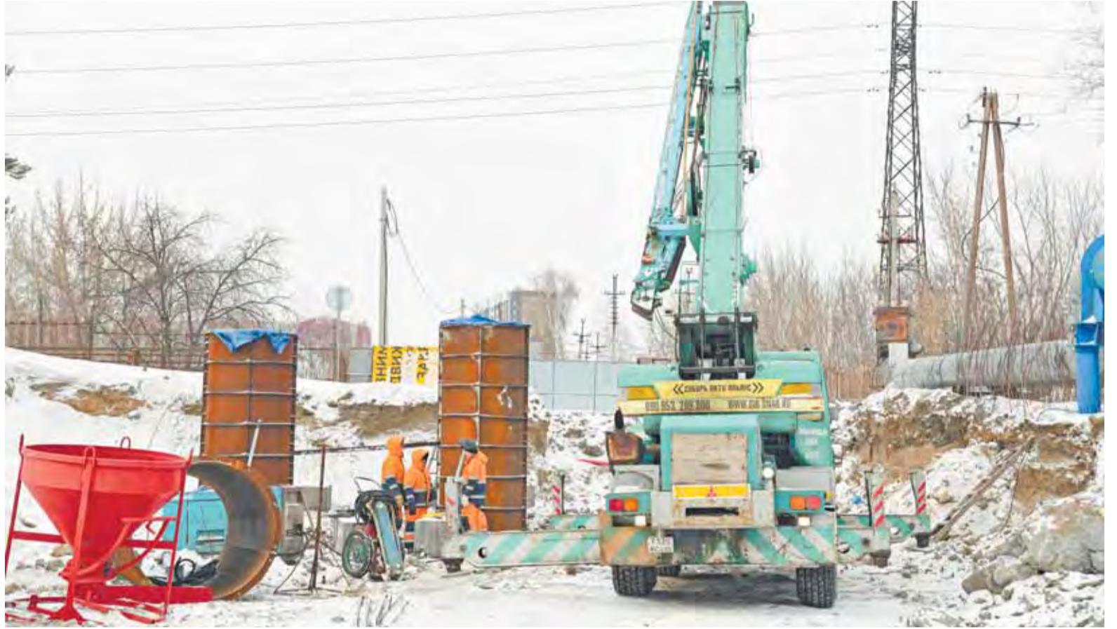
Мостостроители ведут работы в штатном режиме.
