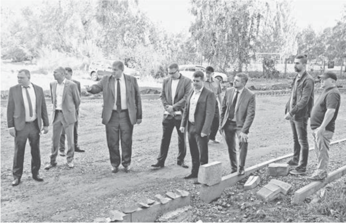
Ремонт двора на ул. Энтузиастов, 28, завершится к середине сентября.
